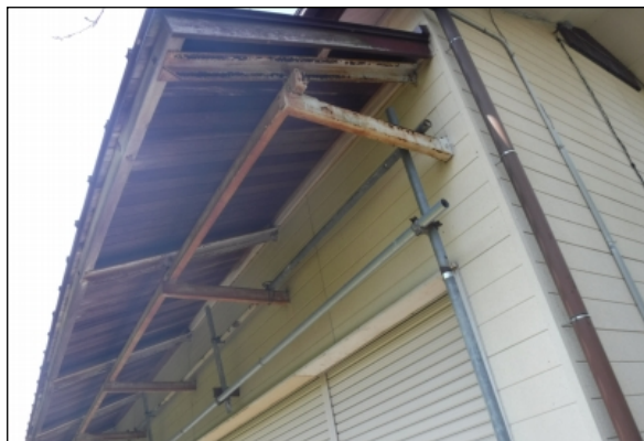
図 3-9 射場[軒骨組み](足場材で補強)
