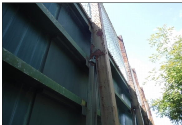
図 3-7 テニスコート[壁打ち](支柱の錆)
